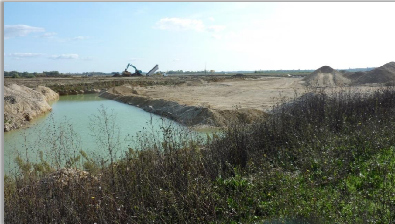
Figure 15 : Vue sur la carrière en cours de remblaiement au sein de la zone d'implantation potentielle
