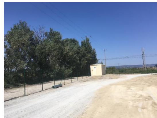
Figure 10 : Exemple de poste de livraison
