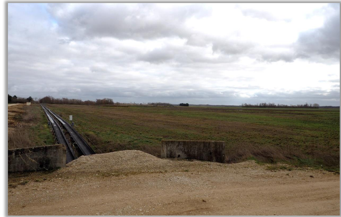
Figure 6 : Vue sur la bande transporteuse au Nord de la zone centrale
