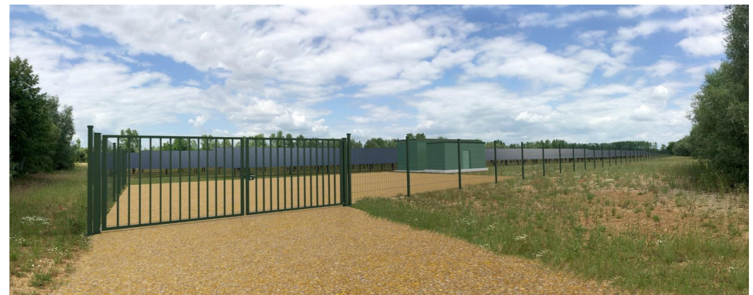
Figure 24 : Vue sur le poste de livraison depuis la RD 50
